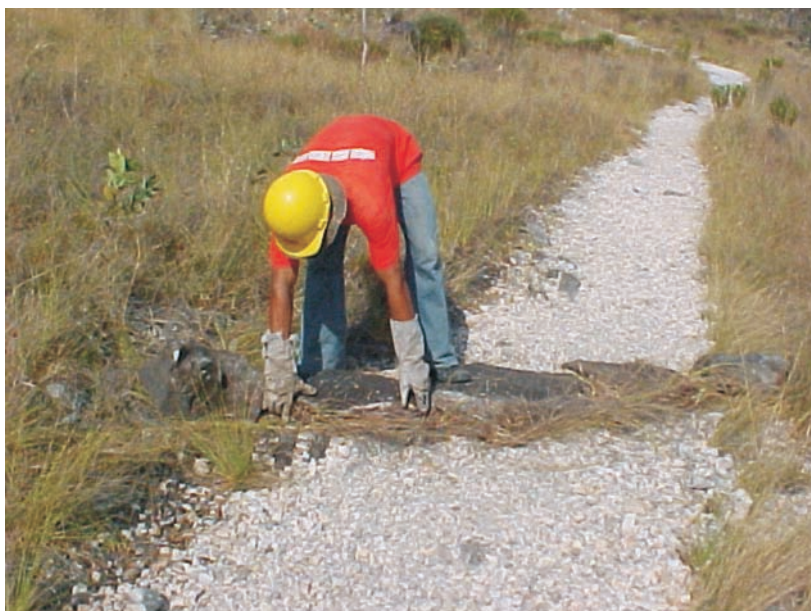
FIGURA 56 – Barreira de escoamento em pedra – Trilha dos Saltos – Parque Nacional da Chapada dos Veadeiros – GO.
