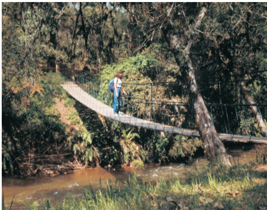
FIGURA 68 – Ponte pênsil – Trilha das Quatro Pontes – Parque Estadual de Campos do Jordão – SP.
