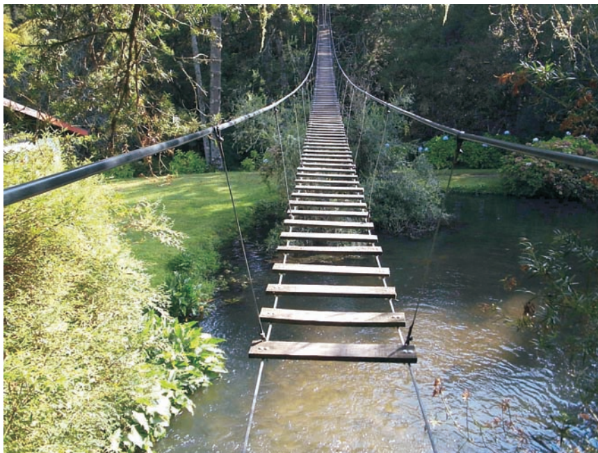
FIGURA 65 – Ponte pênsil – Área de Recreação – Parque Estadual de Campos do Jordão – SP.
