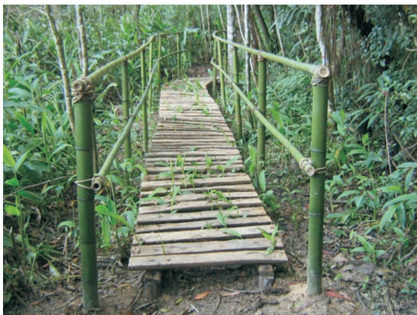
FIGURA 82 – Passarela em madeira – Trilhas das Canelas – RPPN Paiol Maria – São Lourenço da Serra – SP.
