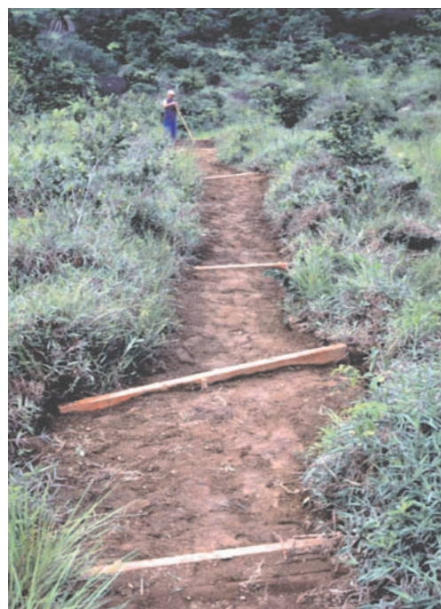
FIGURA 55 – Barreira de escoamento em madeira – Trilha do Vale da Lua – Alto Paraíso de Goiás (São Jorge) – GO.
