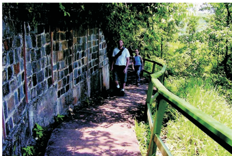
FIGURA 40 – Pavimentação do piso em concreto – Parque Nacional do Iguaçu – PR.
