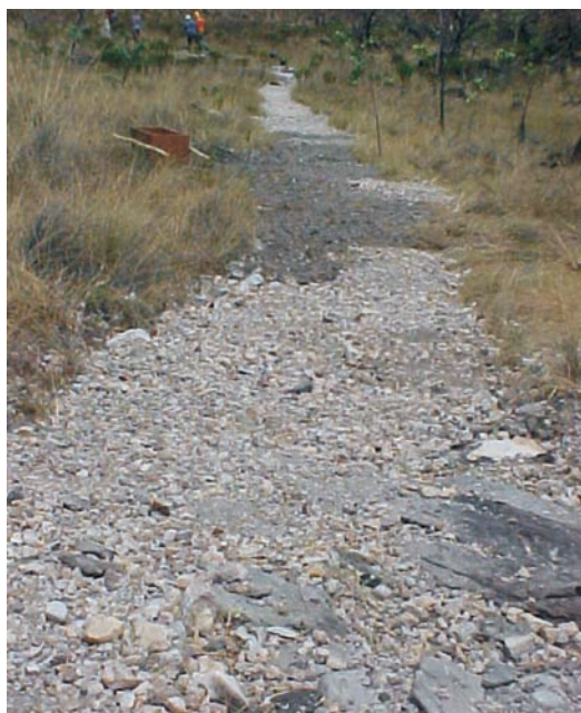
FIGURA 36 – Piso regularizado – Parque Nacional da Chapada dos Veadeiros – GO.
