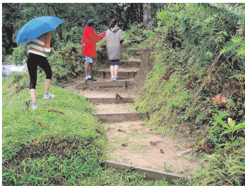
FIGURA 45 – Degraus de madeira – Trilha do Rio Paraíba – Parque Estadual da Serra do Mar – SP (Núcleo Cunha).
