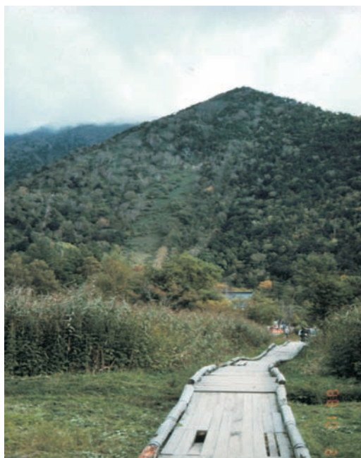
FIGURA 39 – Pavimentação do piso em madeira – Parque Nacional das “Montanhas Centrais” – Japão.
